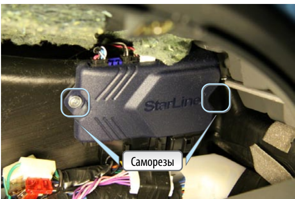
Фото 6. Крепление блока сигнализации
