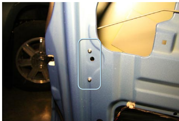
Фото 19.1. Крепление привода к металлу двери
